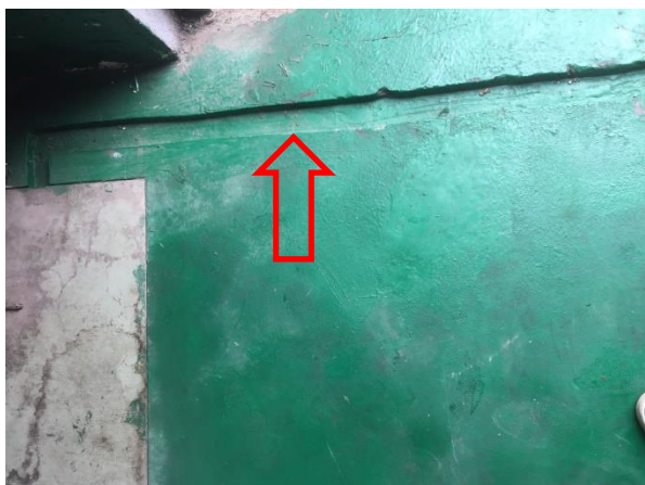
化学品贮存区导流沟
