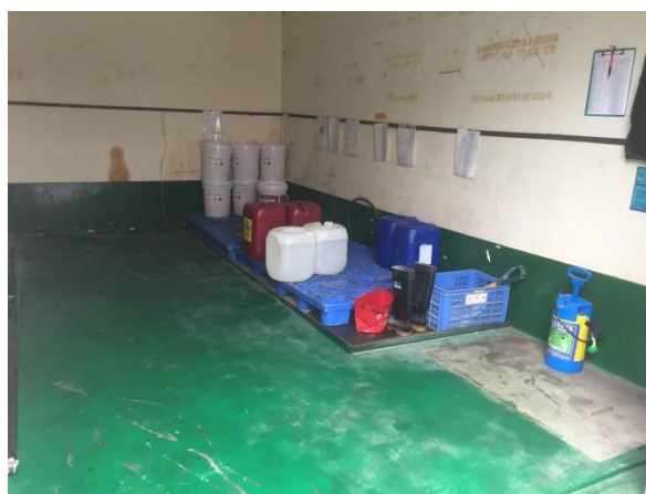
化学品仓库地面防渗漏措施
