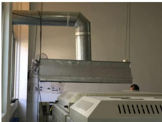
图 10.1-2 上油废气收集设施
