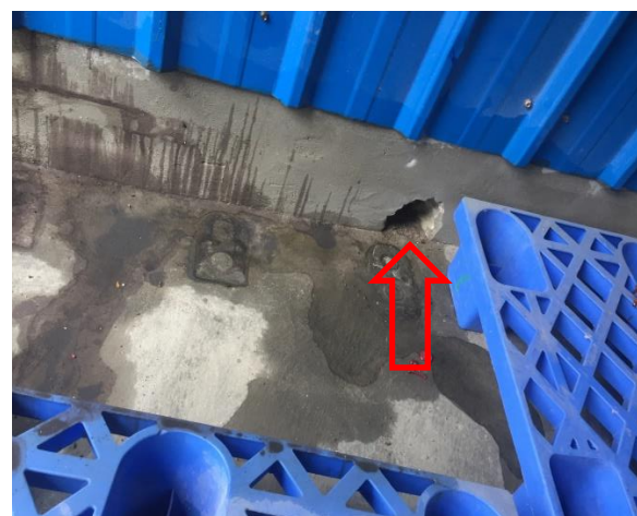
危险废物仓库导流沟
